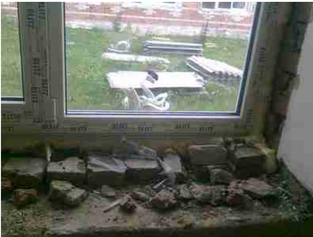
Помещение освобождено от строительного мусора,
